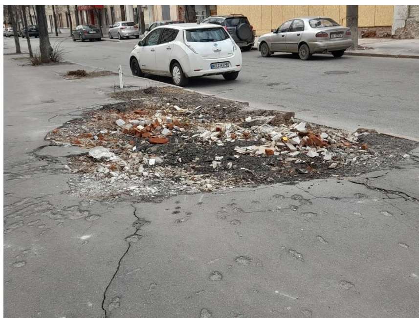
Рис. 2.11 Характер воронки від вибуху осколково-фугасної бомби калібру 250 кг (ОФАБ-250), підривач установлений на миттєву (осколкову) дію (м. Харків)
