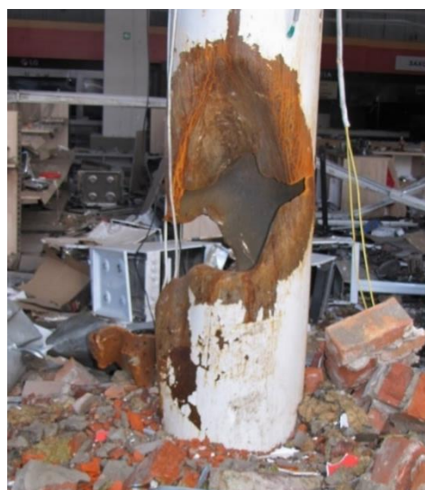
Рис. 2.33 Детальний вигляд наскрізного пошкодження центральної колони
