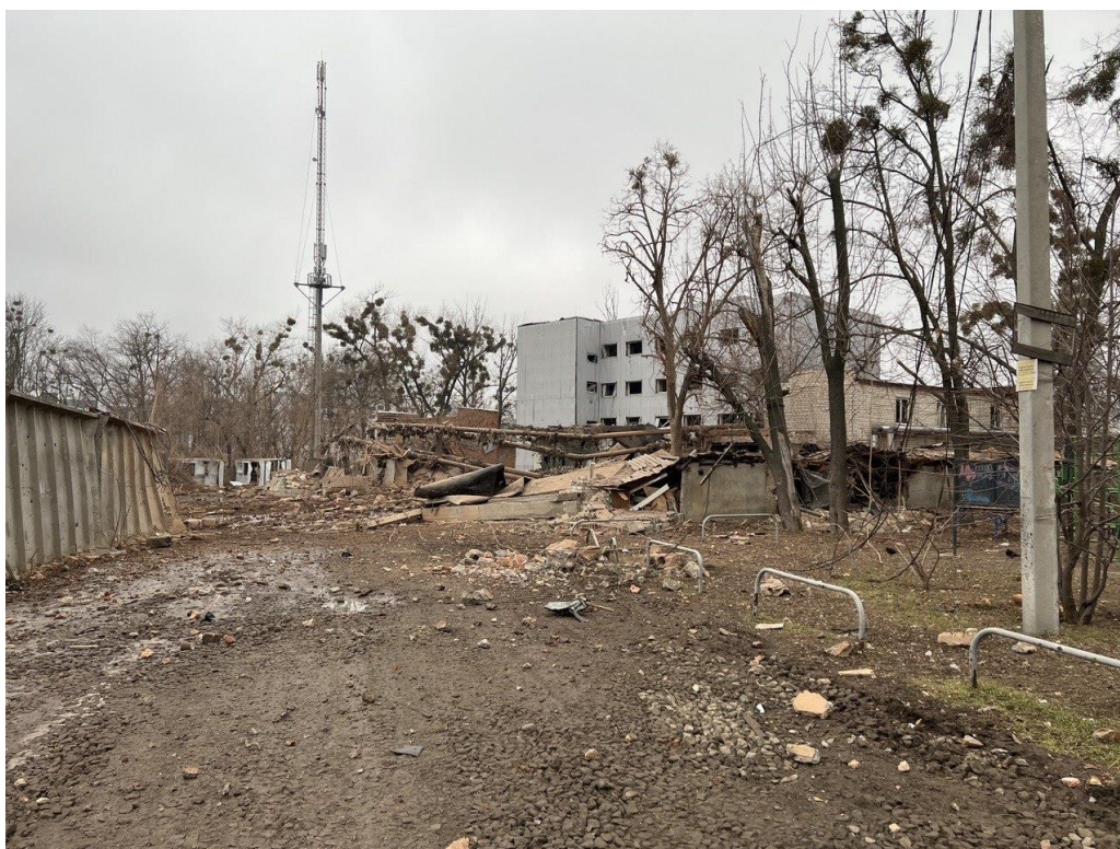
Рис. 2.37 Загальний вигляд місцевості, де розташована досліджувана нежитлова будівля, після вибухів
