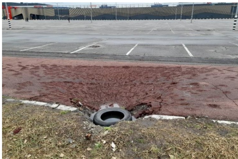
Рис. 2.8 Характер поля розльоту осколків, влучання від яких відобразилося на покритті автомобільної стоянки; влучання і вибух 122 мм некерованого осколково-фугасного реактивного снаряда РСЗВ «Град» (Салтівка, м. Харків)
