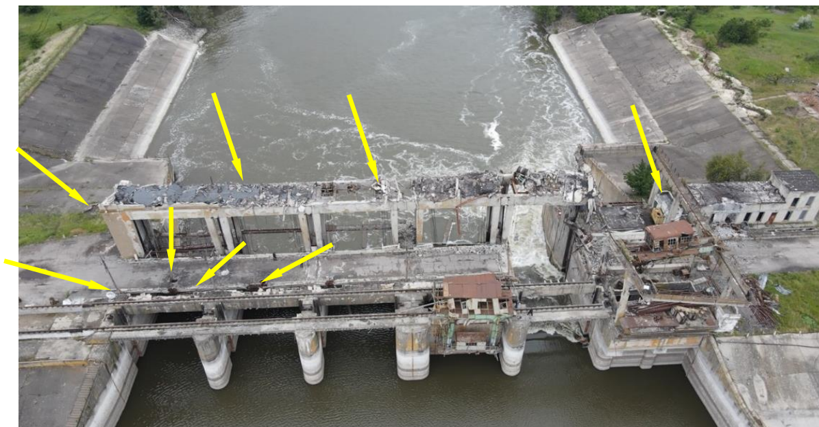
Рис. 2.17. Загальний вигляд місць розташування воронки від вибухів авіаційних бомб ФАБ-250 та авіаційних ракет Х-59, які локалізовані на території гідровузла; місця влучань позначено стрілками
