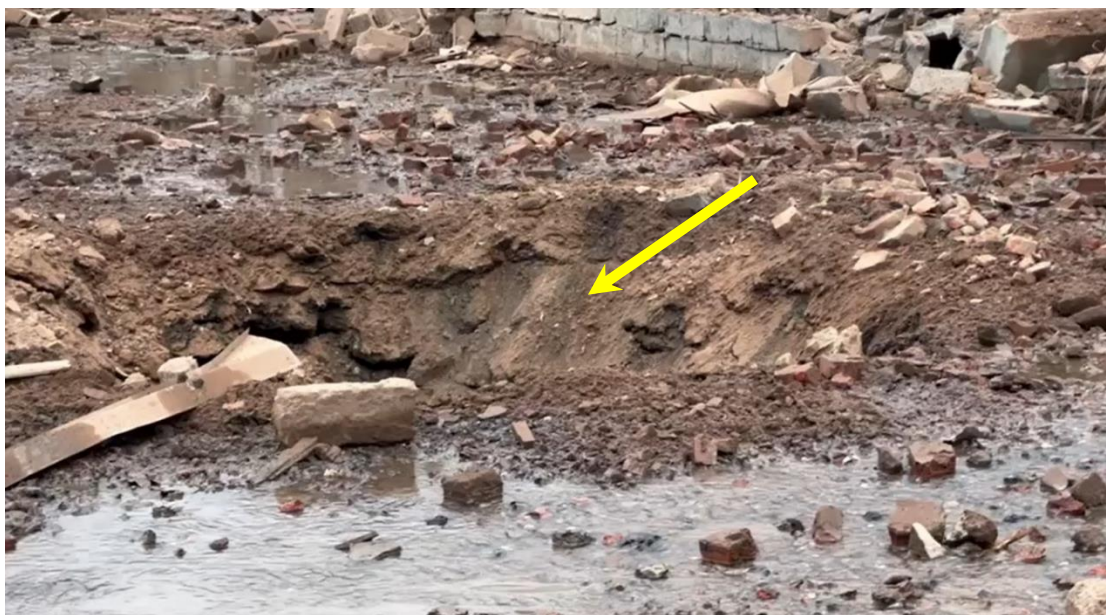
Рис. 2.39 Загальний вигляд другої воронки, яка розташована попереду фасаду досліджуваної нежитлової будівлі; стан після вибуху (позначено стрілкою)
