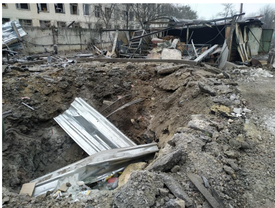
Рис. 2.19 Воронка від вибуху на місці стоянки автомобільного транспорту, утворена в результаті прямого влучання й вибуху зенітної керованої ракети типу 5B55 (м. Харків)
