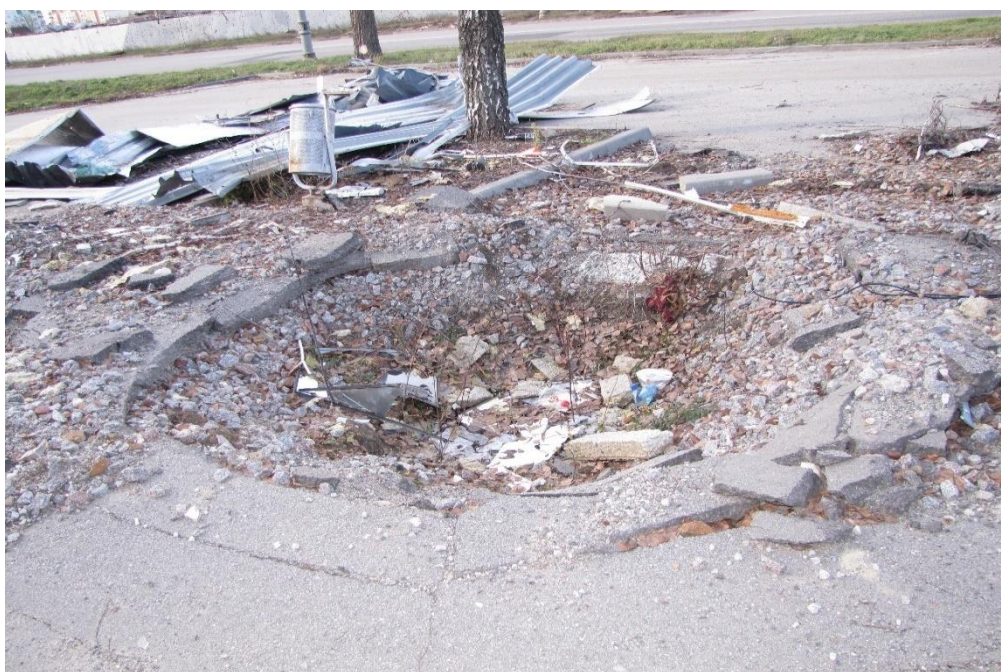
Рис. 2.6 Характер воронки в асфальтовому покритті від влучання й вибуху 120 мм осколково-фугасної мінометної міни (Північна Салтівка, м. Харків)
