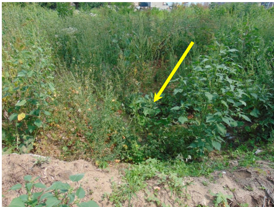
Рис. 2.40 Загальний вигляд третьої воронки, розташованої попереду фасаду досліджуваної нежитлової будівлі (позначено стрілкою); стан на момент проведення огляду
