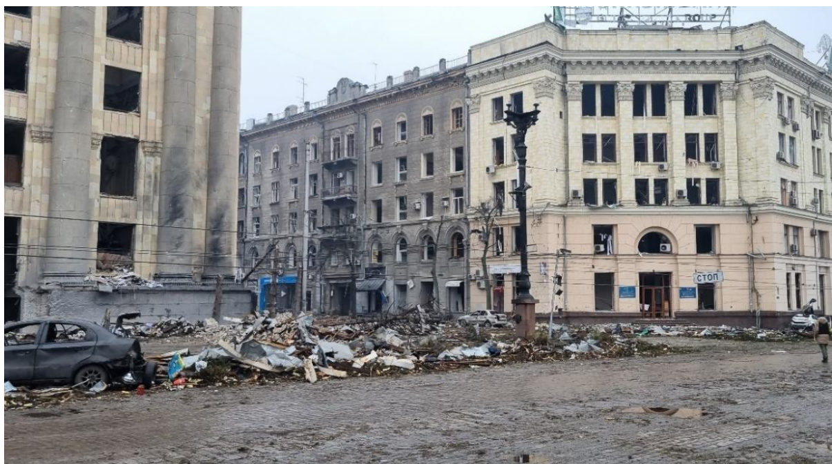
Рис. 2.14 Характер пошкоджень вулиці після вибуху бойової частини крилатої ракети 9М727 (м. Харків)
