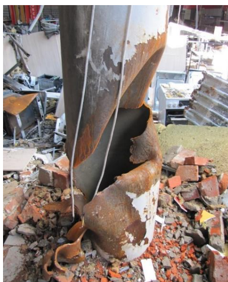
Рис. 2.33 Детальний вигляд наскрізного пошкодження центральної колони
