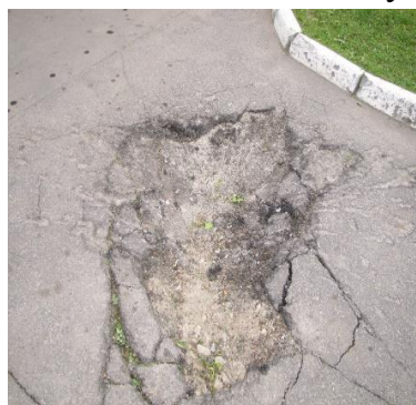
Рис.2.3 Характер воронки та стану дорожнього покриття після влучання 152 мм осколково-фугасного артилерійського снаряда калібру 152 мм (м. Харків); підривач був установлений на миттєву (осколкову) дію
