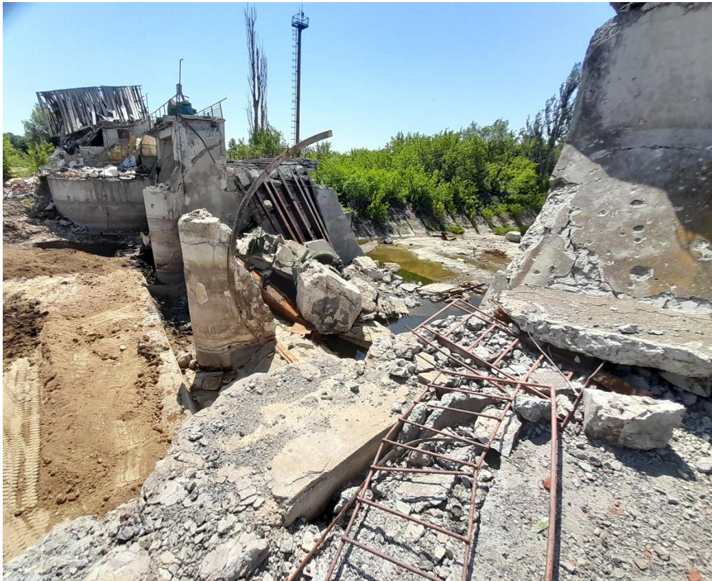
Рис. 2.20 Характер руйнування гідровузла, по якому проходила автомагістраль, у результаті прямого влучання зенітної керованої ракети типу 5B55 (Донецька область)
