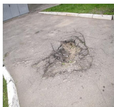
Рис. 2.4 Характер пошкодження асфальтового покриття (воронки) на автомобільній дорозі; характер прямого влучання в дорожнє покриття 122 мм осколково-фугасного некерованого реактивного снаряда «М-21ОФ» індексу «9М22» («9М22У», «9М22У-1», «9М22У-2») з осколково-фугасною головною частиною «9Н51», які використовуються для стрільби з реактивних систем залпового вогню «Град» (м. Харків)
