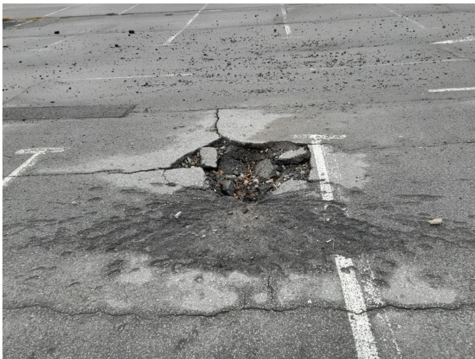
Рис. 2.7 Типовий характер пошкоджень асфальтового покриття, завданих у результаті влучання 122 мм некерованого осколково-фугасного реактивного снаряда РСЗВ «Град» (Салтівка, м. Харків)
