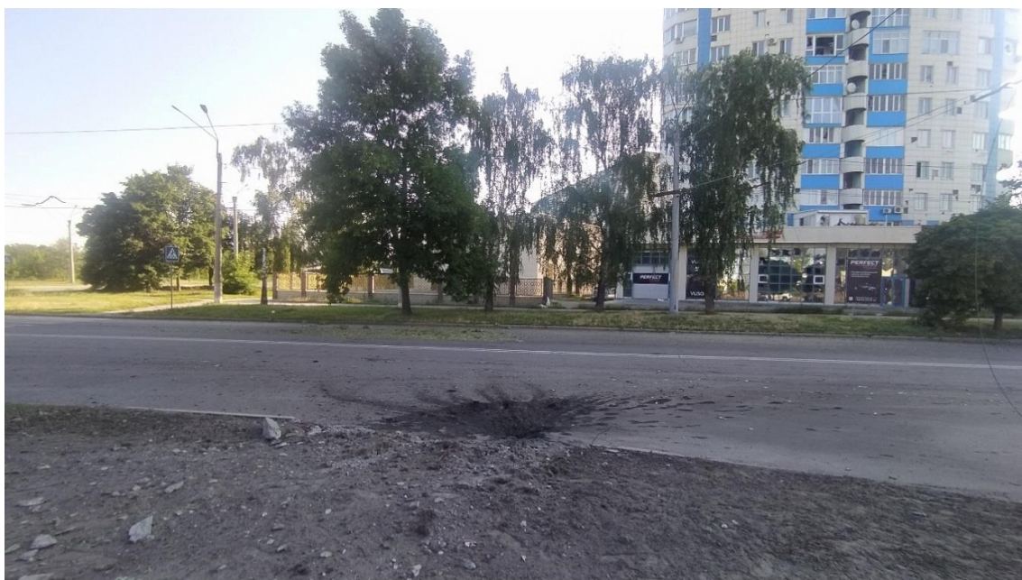
Рис.2.3 Характер воронки та стану дорожнього покриття після влучання 152 мм осколково-фугасного артилерійського снаряда калібру 152 мм (м. Харків); підривач був установлений на миттєву (осколкову) дію
